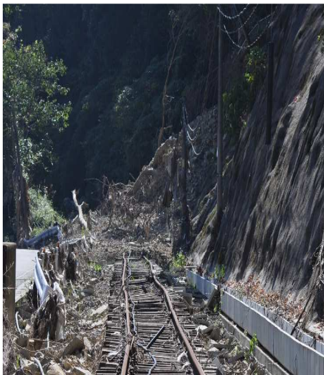
一勝地駅から球泉洞駅間の線路 土砂崩壊し線路も湾曲している！
