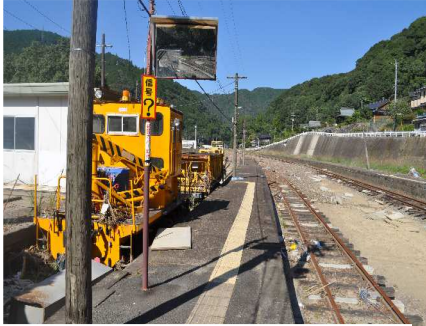
残された保守用車。エンジンルームまで砂がずっしり詰まっている。
