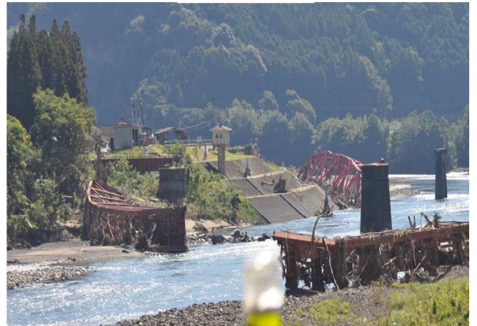
道路の橋もほとんどが崩落
