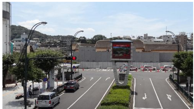
【解体工事が進む旧諫早駅舎、現在仮駅舎で営業】
