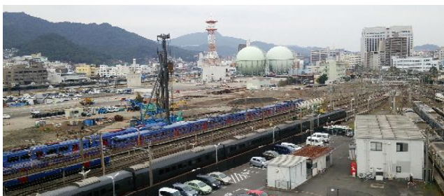
【高架工事が進む長崎駅構内】
