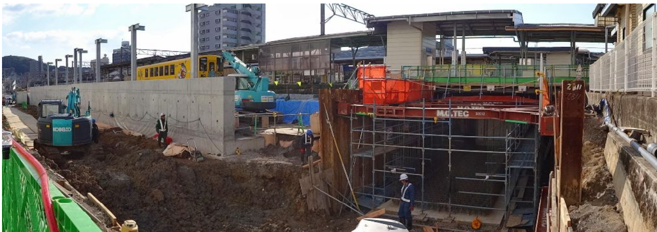
【仮駅舎に関わる諫早駅の工事（島原鉄道ホーム付近）】
